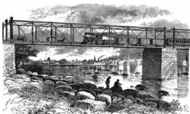
13. Pociąg Pennsylvania Railroad na drogowo-kolejowym moście na rzece Delaware pod Trenton, pierwszym żelaznym, który w 1875 r. zastąpił drewniany z 1804 r William B. Sipes, The Pennsylvania Railroad: Its Origin, Construction, Condition, and Connections, Pennsylvania Railroad Co., Philadelphia, 1875; PD, WikiComm
