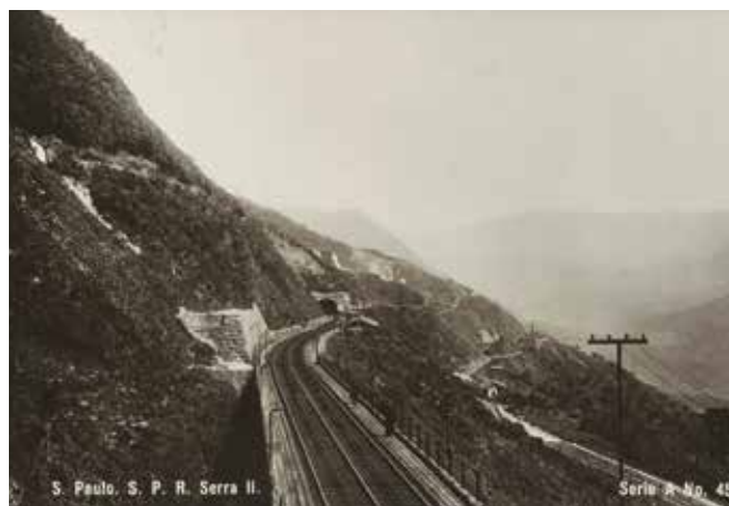
3. Trójszynowa trasa na odcinku linowym linii Santos – Sao Paulo z 1901 r. źr.: fot. Guilherme Gaensly, 1905-10, kolekcja: Biblioteca Digital Luso-Brasileira
