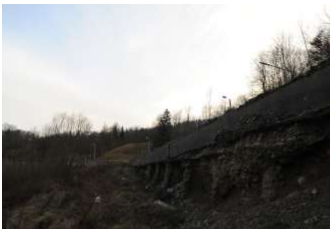
Rys.1.2. Odstąpięte podłoże pod drogą wojewódzką wskutek osunięcia skarpy głównej osuwiska.
