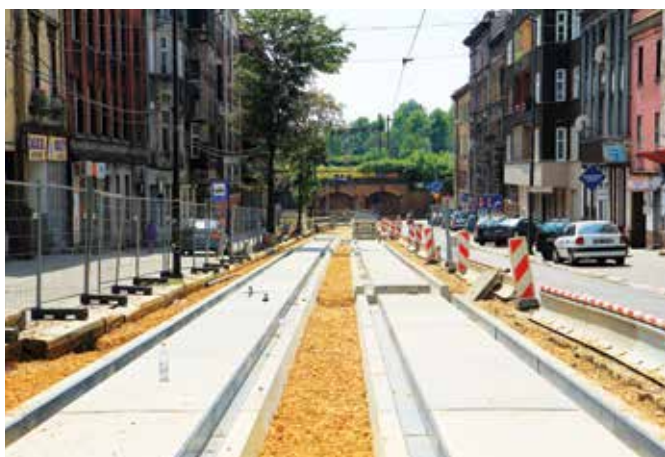
Modernizowane torowisko na ul. Jagiellońskiej w Bytomiu
