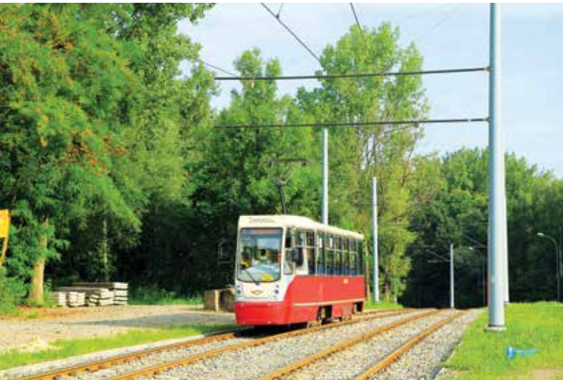
Zmodernizowany w MPK Łódź wagon 105N-2K numer 732 na linii 7 na odbudowanym torowisku w ul. Łagiewnickiej w Bytomiu
