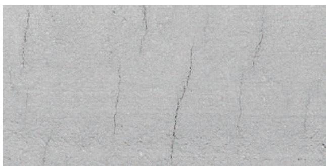
Rys. 5. Rysy wzdłuż przebiegu zbrojenia górnego
