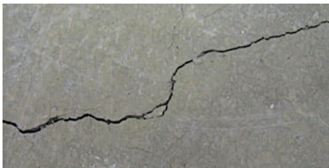
Rys. 4. Rysy wskrośne
