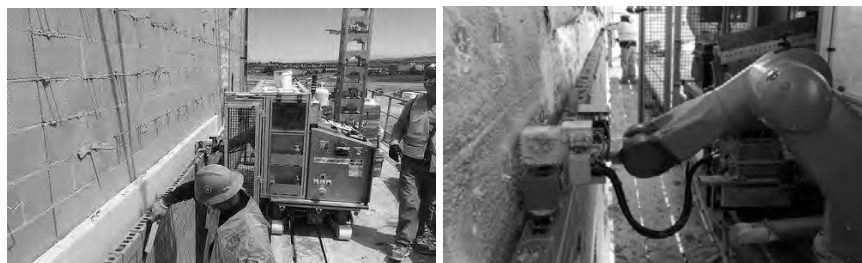
Rys. 1. Robot SAM100 podczas pracy [20]
