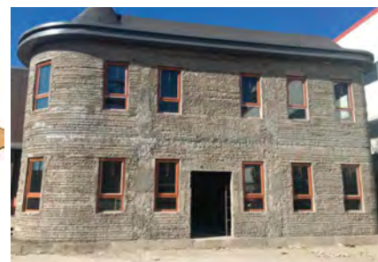
Rys. 7. Drukowanie przestrzenne budynku; a) idea metody Contour Crafting [40], b) pierwszy całkowicie „drukowany” budynek – firma HuaShang Tengda [41]
