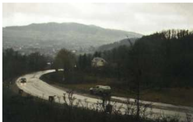
Rys.2. Deformacja nawierzchni drogi DK75 [2]
