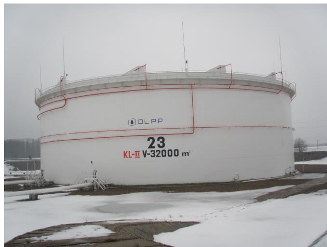
Rys. 2. Zbiornik jedno płaszczowy z osi pionowej z dachem pływającym o pojemności 32000 m 3 .
