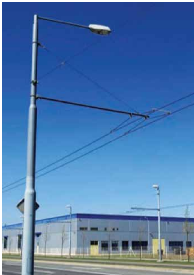
Fot. 1. Zawieszenie poprzeczne wahadłowe. Podwieszenie przewodów trakcyjnych na wysięgnikach – typ Delta [6]
