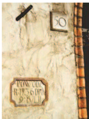
Rys. 2. Tablica powodziowa u wejścia do kamienicy na Starym Rynku 50 w Poznaniu (fot. B. J. Wosiewicz)
