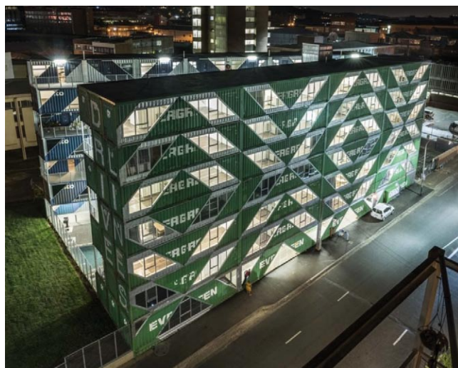
Rys. 4. Budynek wielorodzinny z kontenerów w Johannesburgu na 100 mieszkań zasilanych energią słoneczną i wykorzystujących wodę deszczową [11]
