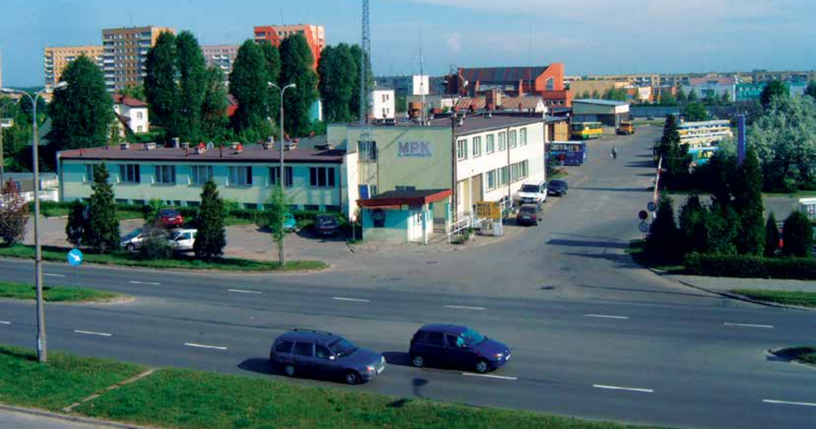
Fot. 1. Budynek administracyjny MPK i fragment zajezdni
