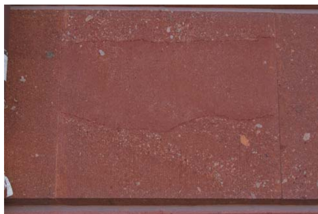
Ryc. 2. Warstwowanie i struktury erozyjne w piaskowcu norwudzkiem (ul. Kuźnicza; długość pola widzenia ok. 70 cm). Ryc. 2, 8, 11–15 fot. P. Zagożdżon
