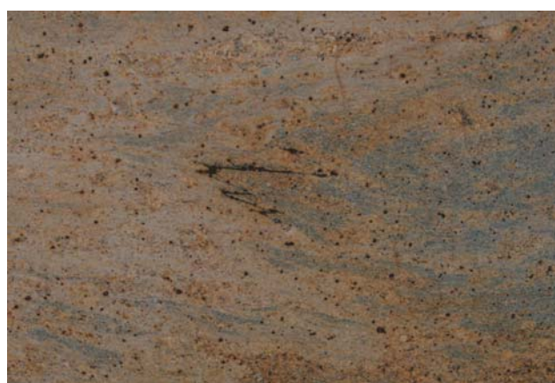
Ryc. 11. Transpozycja foliacji w gnejsie Kashmir Gold (róg ul. Bolesława Prusa i Generała Józefa Bema; długość pola widzenia ok. 60 cm)
