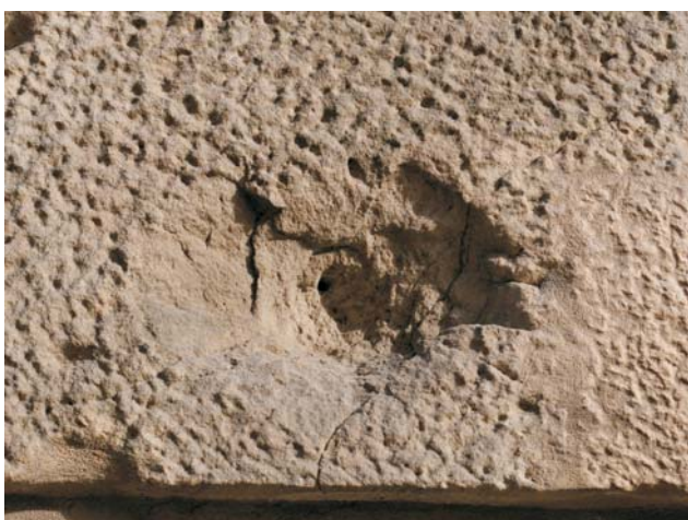
Ryc. 14. Pozostałość ostrzału z broni ręcznej z okresu oblężenia Festung Breslau, w centralnej części ubytku widoczny ślad po pocisku (południowa ściana Kościoła Uniwersyteckiego; długość pola widzenia ok. 35 cm)
