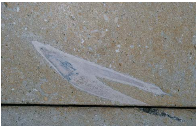
Ryc. 13. Kość gruba kręgowca w płycie elewacyjnej Dolomitu (róg ul. Kazimierza Wielkiego i Świętego Mikołaja; długość pola widzenia ok. 30 cm)
