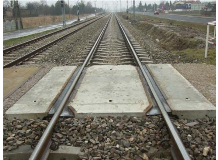
Fot. 6. Szlak Cz-a Gnaszyn–Blachownia, nawierzchnia z płyt CBP [fot. A. Dąbrowski]
