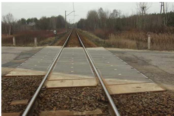
Fot. 4. Szlak Krusze–Pilawa, nawierzchnia z płyt MIROSLAW [fot. A. Dąbrowski]
