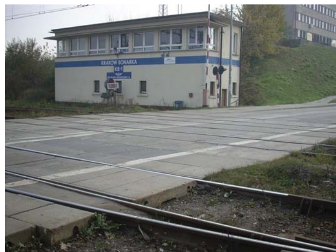
Fot. 5. Płyty ZET (pierwowzór płyt PGP) na st. Kraków Bonarka [fot. G. Stencel]
