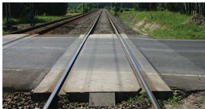
Fot. 2. Okolice p.o. Przylep, nawierzchnia z płyt EDILON LC-L [fot. G. Stencel]
