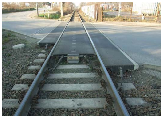
Fot. 3. Stacja Kraków Prokocim Tow., nawierzchnia z płyt STRAIL [fot. A. Dąbrowski]
