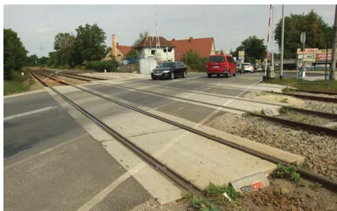
Fot. 1. Stacja Nysa, nawierzchnia z płyt STELCON [fot. A. Dąbrowski]
